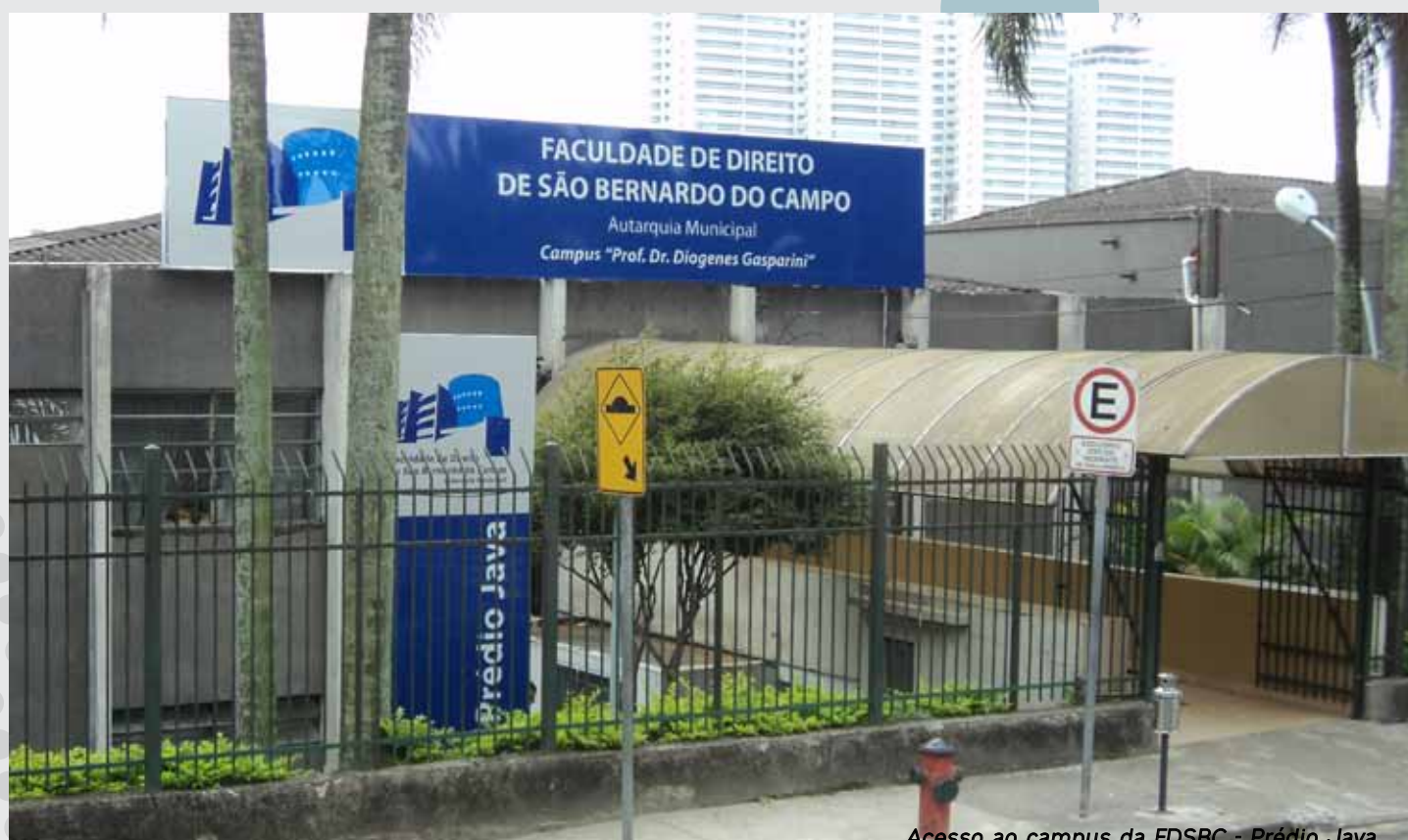
Acesso ao campus da FDSBC - Prédio Java
